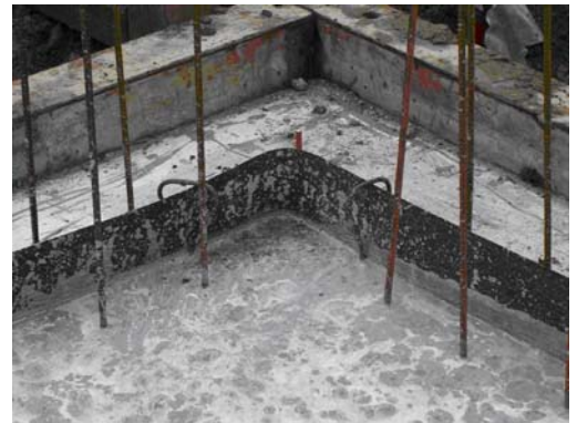
CEMflex VB Verbund- und Dichtblech CEMflex VB special coated steel blade waterstop
