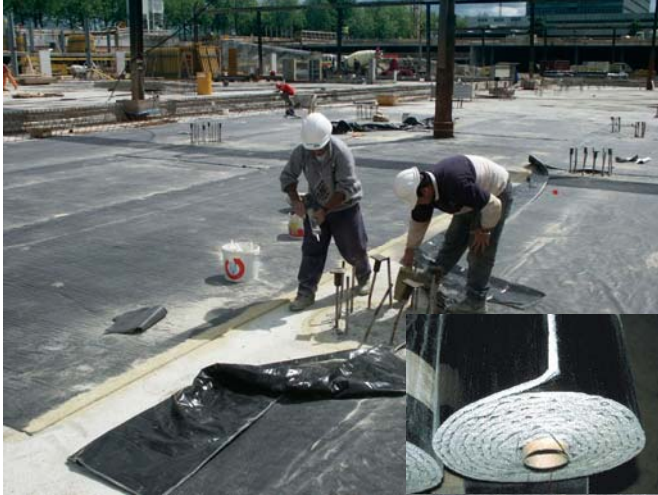
Bauwerksabdichtung Basement waterproofing
